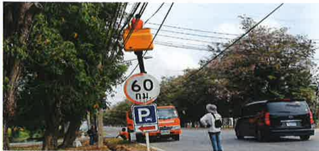
โครงการติดตั้งสายสัญญาณไฟเบอร์อปติก
